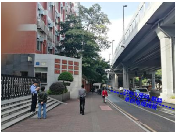
220kV 鹿鸣~麒麟线路路径 3
